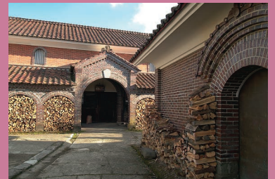
② 喜多方のレンガ蔵(喜多方向) Kitakata- Brick Warehouse (Kitakata City)
