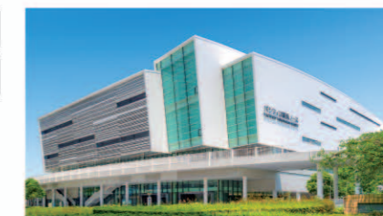
エントランス側外観
