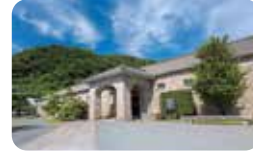
● 旧集成館機械工場
