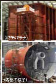
【止水試験のための実規模試験体】 提供:国際廃炉研究開発機構(IRF)
