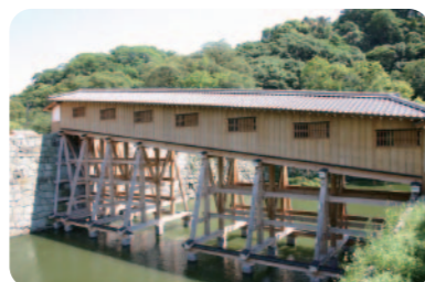
和歌山城 御橋廊下
