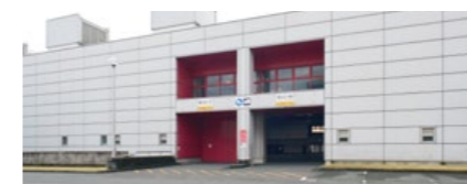
南館搬入口(幅5m、高さ4m)
