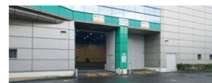
北館搬入口(幅4.6m、高さ5.2m)
