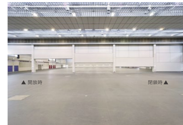
昇降壁 A・BC区画は、昇降式の壁で仕切ることが出来ます。
