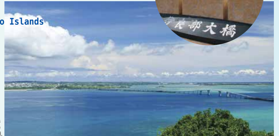
伊良部大橋 Iribu Bridge
